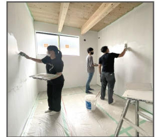
▲壁塗り当日の様子
