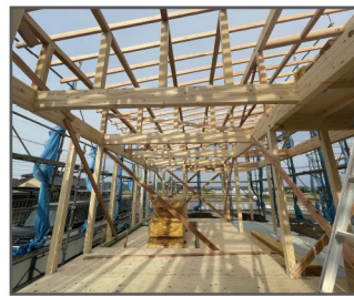
▲こちらはLDK!天井は片流れ×吹き抜けで、開放的に。
